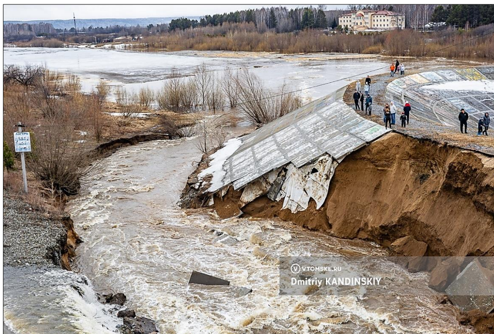
Рис. 7. Размыв дороги на Сенную Курью и разрушение части новой дамбы вблизи Коммунального моста, 2024 год ( https://info.sibnet.ru/article/287079/ ).
