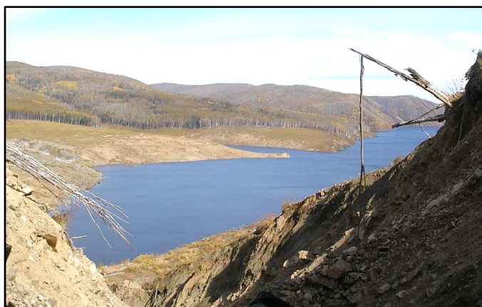
Рис. 5. Следы разрушительного заплеска волны вверх по водохранилищу; заводь водохранилища со скоплением плавника (фото В. Е. Кириллова)
