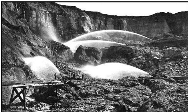
Рис. 27. Добыча золота гидравлическим методом в Калифорнии (<http://economic-definition.com/images/4019248662.jpg>)
