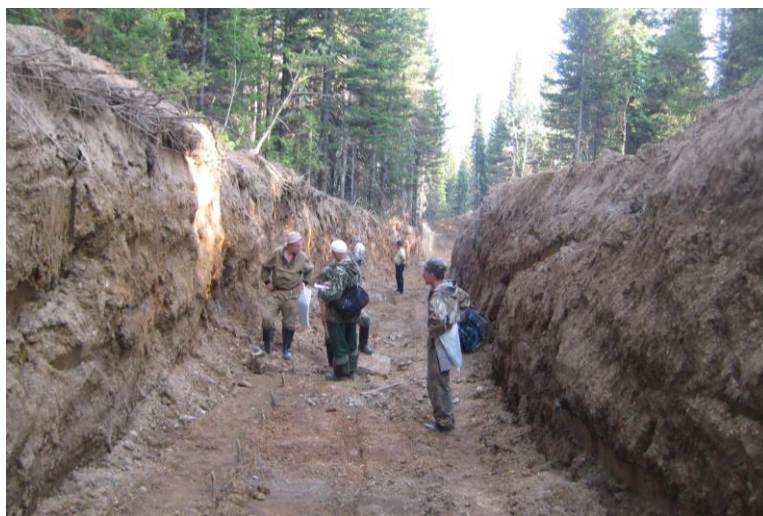
Рис. 2. Поисковая бульдозерная канава на водоразделе Ортона и Черной речки (фото Бутвиловского В.В.).
